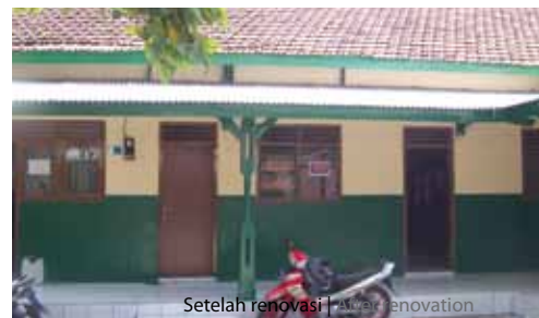
Setelah renovasi | After renovation
